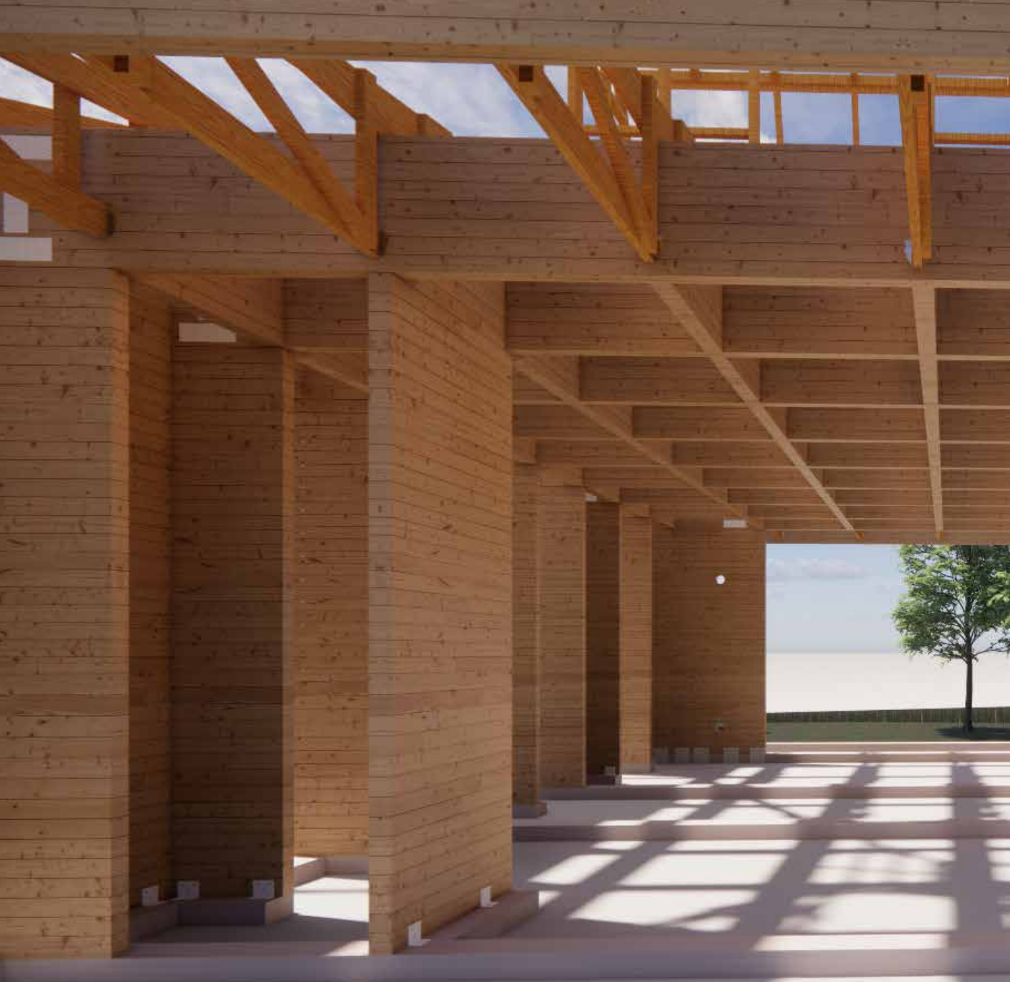
Figura 23: Imagen de la estructura en CLT y vigas laminadas. Proyecto Future Edu Space
